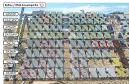
Fig. 13. Inventario de muestras de termorrociado dual Zn/Al con signos de deterioro por corrosividad atmosférica (círculos rojos). 12 meses de exposición en La Voz.
